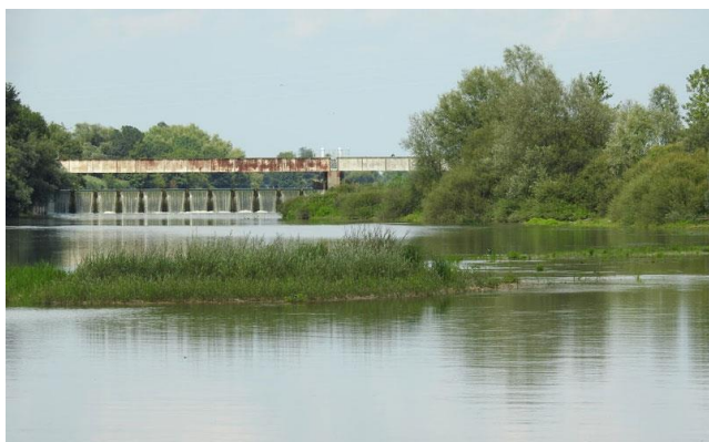
Photo 2 : le 21 juillet, le banc de graviers est en grande partie inondé (A.Fleixas)
